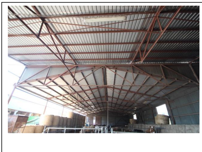
Foto 122 – pohled na ocelovou konstrukci Střechy – štítová stěna
