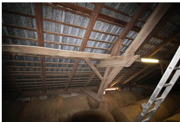
Foto 165 – pohled na dřevěnou konstrukci střechy
