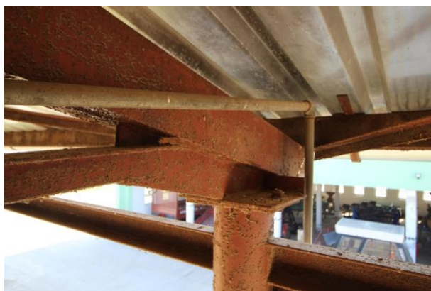
Foto 094 – pohled na ocelovou konstrukci střechy
